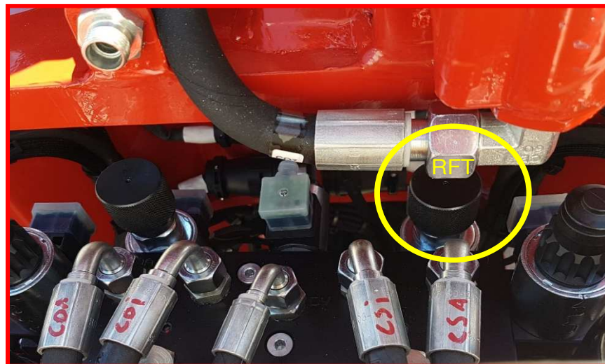
Figure 26 : vanne droite du banc de filtres.
